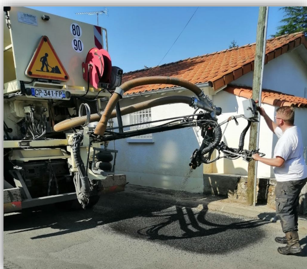
Chantier rue du rompis
